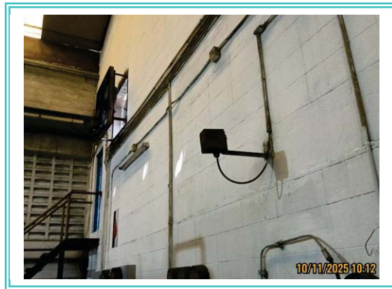
รูปที่ 3-43 ติดตั้ง Gas Leak Detector
